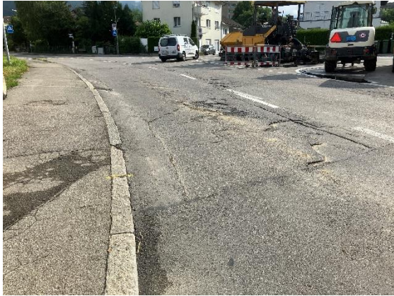
Belagsschäden Strasse (Belagsausbrüche, Belagsablösungen, Risse)
