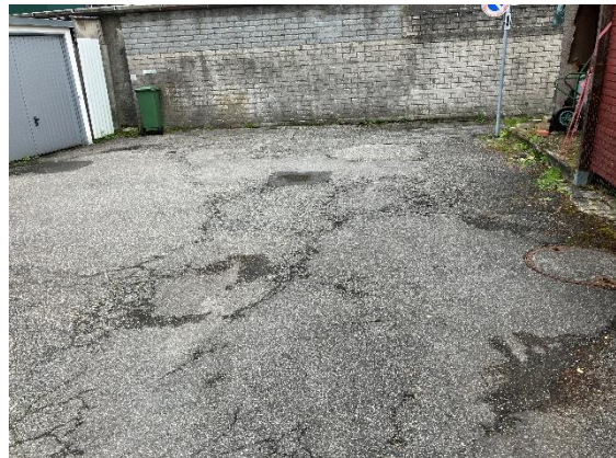
Belagsschäden (Risse, Belagsausbrüche, Unebenheiten) und schadhafte Randabschlüsse
