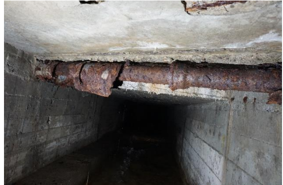
Decke: stark korrodierte Werkleitung innerhalb des Bachprofils
