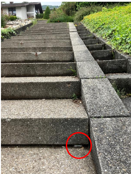
Treppenanlage: Hohlstellen/Keile, Verschiebungen, fehlender Handlauf
