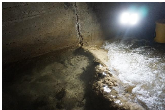
Boden: Kalkablagerungen («Kalkwülste») quer zum Kanal
