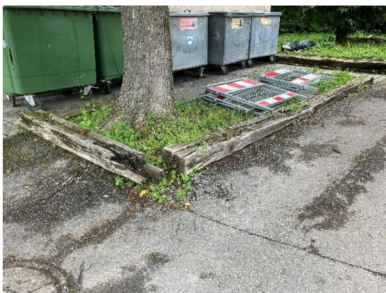
Vermoderte Eisenbahnschwellen als Randabschluss
