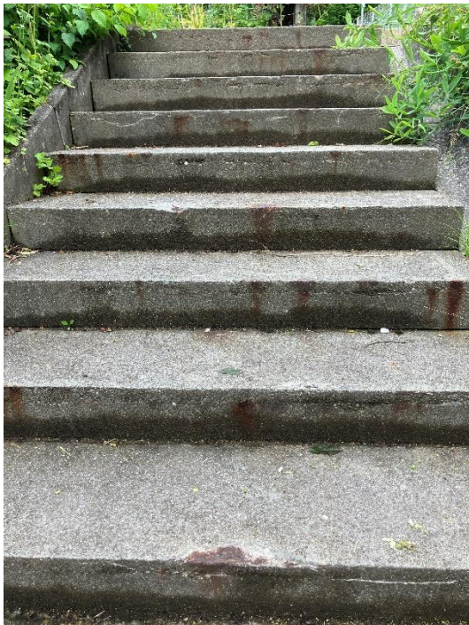
Treppenstufen: korrodierende Bewehrung
