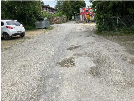
Belagsschäden (Belagsausbrüche, Unebenheiten)
