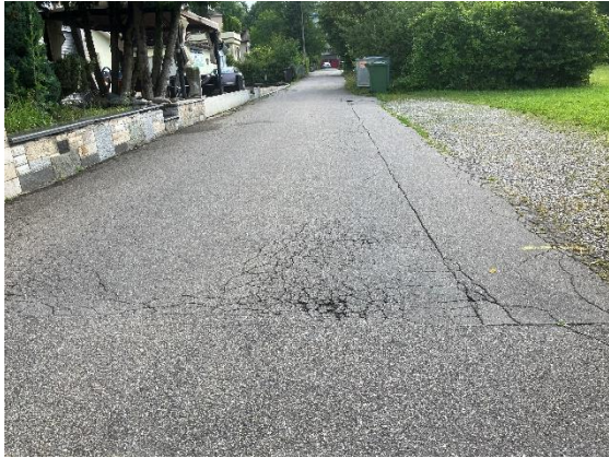
Belagsschäden (Netzrisse infolge Frostschäden, Risse, ausgebrochene Belagsränder)
