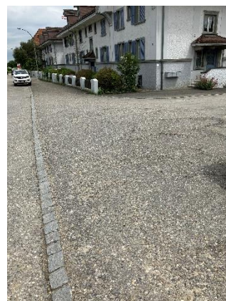
Gehweg: Belagsschäden (Risse, Kornausbrüche) und schadhafte Randabschlüsse
