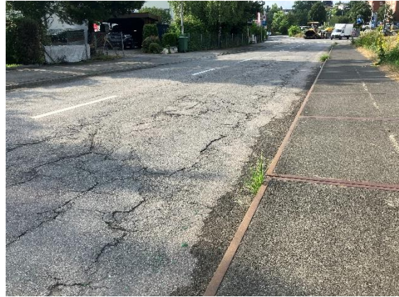
Belagsschäden Strasse (Belagsablösungen, Risse) und Unebenheiten
