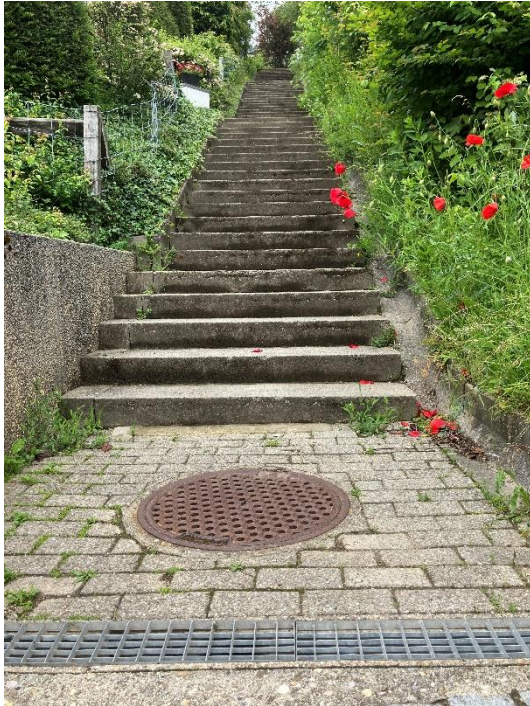
Treppenanlage: fehlender Handlauf
