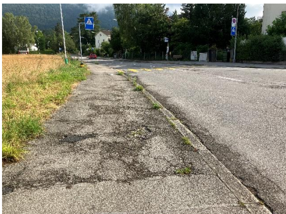
Belagsschäden Gehweg (Belagsaufbrüche, Risse)
