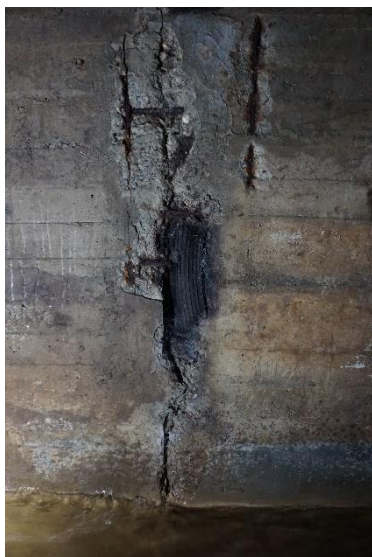
Wand: defekte Dilatationsfuge und Betonabplatzungen über korrodierten Bewehrung
