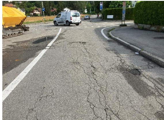
Belagsschäden Zufahrt Denner (Belagsausbrüche, Risse)
