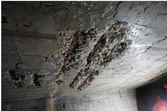
Decke: Betonabplatzungen über korrodierten Bewehrungsseisen
