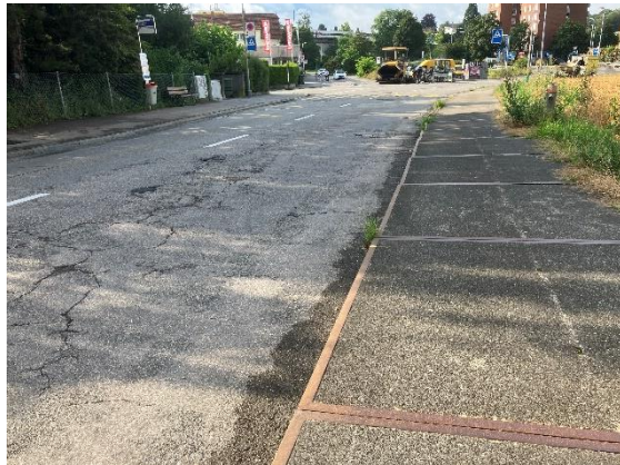
Belagsschäden Strasse (Belagsausbrüche, Belagsablösungen, Risse) und verschobene Betonplatten beim Gehweg
