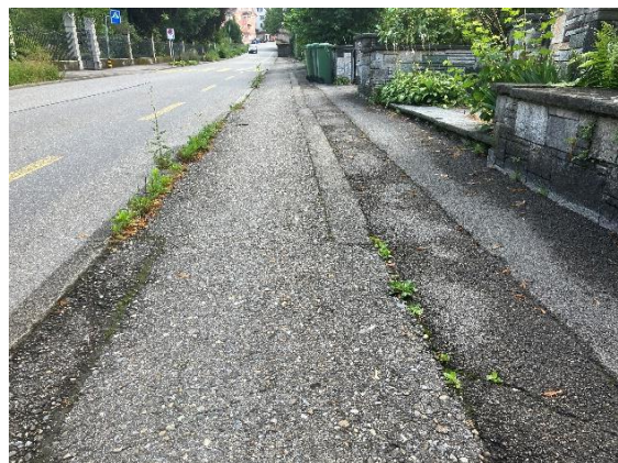
Belagsschäden Gehweg (Risse, Kornausbrüche, mangelhafte Belagsflicke)
