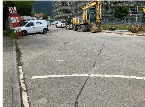
Belagsschäden (Risse, Belagsausbrüche), Belagsflicke und schadhafte Randabschlüsse
