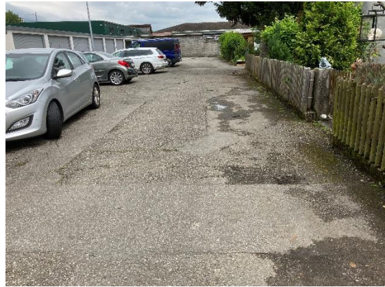
Belagsschäden (Risse, Belagsausbrüche, Unebenheiten) und Belagsflicke
