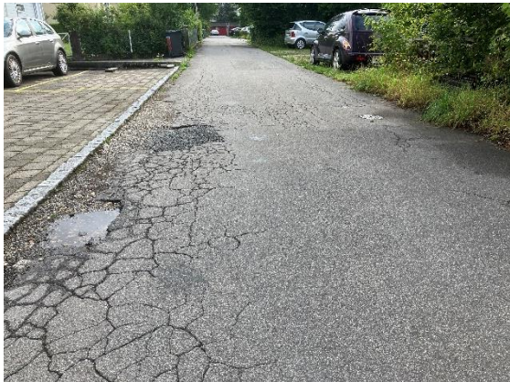
Belagsschäden (Netzrisse infolge Frostschäden, Belagsausbrüche)
