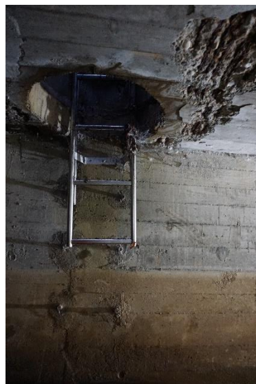
Decke: schadhafter Schachteinstieg
