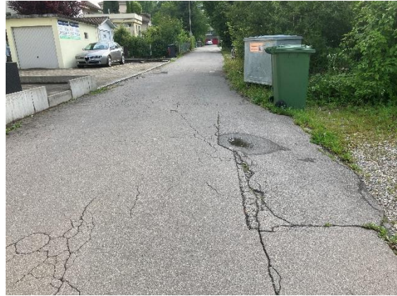
Belagsschäden (Risse, ausgebrochene Belagsränder) und Unebenheiten
