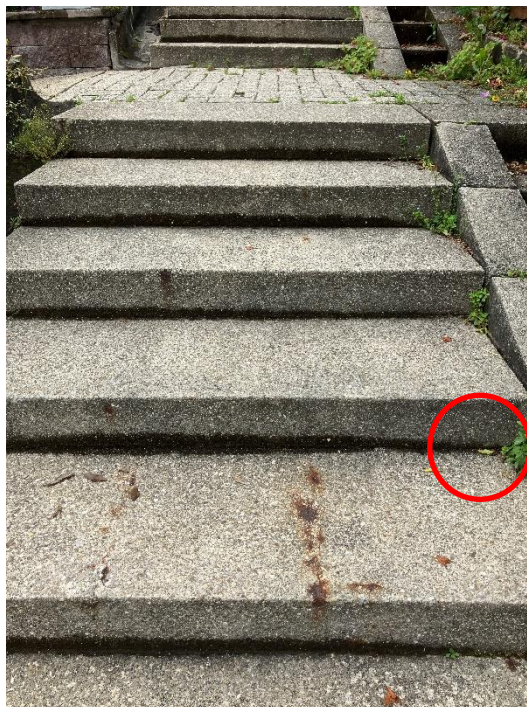
Treppenstufen: Keile und korrodierende Bewehrung
