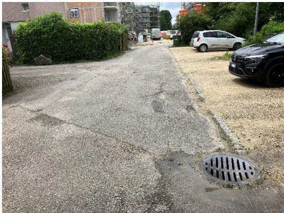
Belagsschäden (Risse, Belagsausbrüche, Unebenheiten) und Belagsflicke
