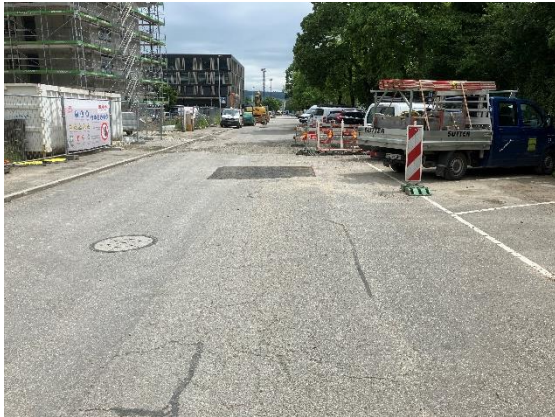
Belagsschäden (Risse) und Belagsflicke
