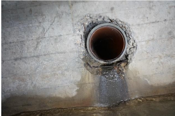
Wand: schadhafter Einlauf mit Grundwasser-eindrang unter der Leitung
