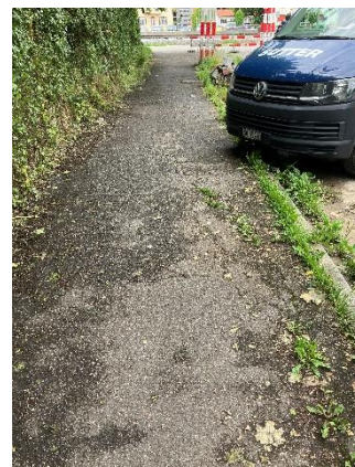
Belagsschäden Gehweg (Risse, Belagsausbrüche)
