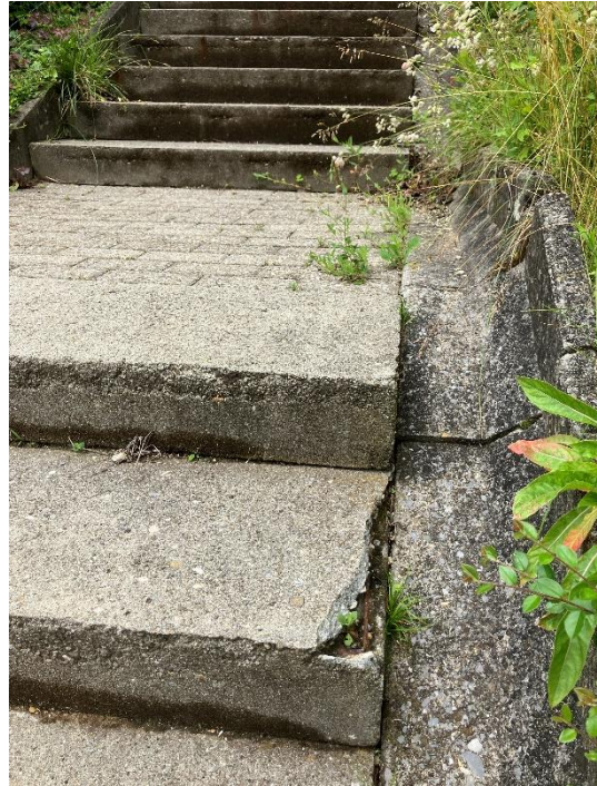
Treppenstufen: Abplatzungen und offene Bewehrung
