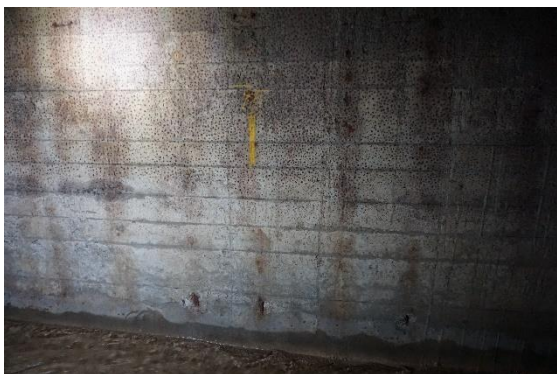
Wand: korrodierte Bewehrungsseisen
