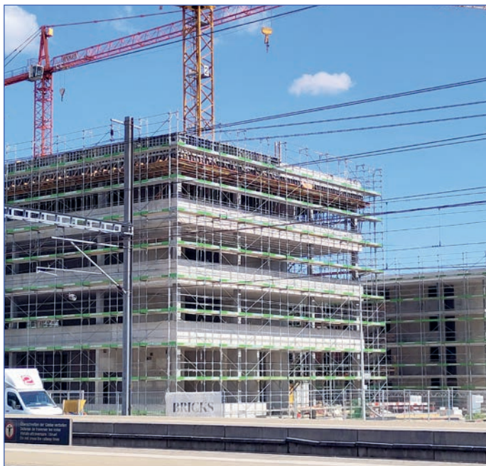
Die letzte Etage ist erreicht: Der Campus Technik beim Bahnhof Süd im Rohbau. Foto vom 11. Mai 2024.
