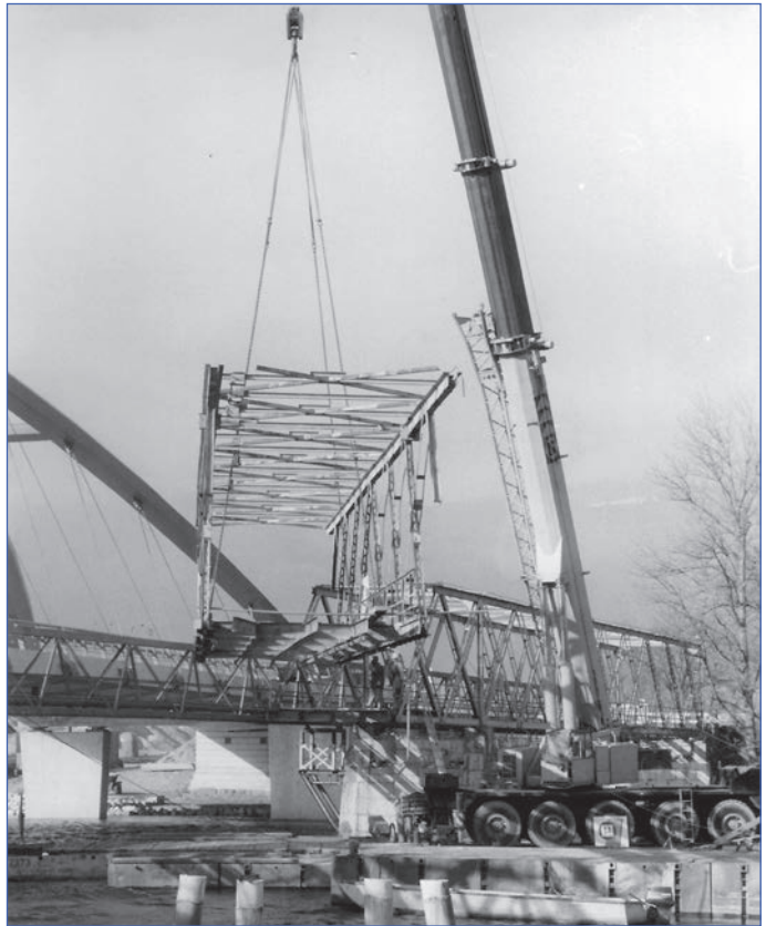
Zerlegung und Abtransport der alten Archbrücke 1998.
