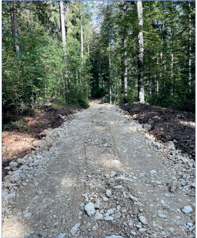
Fuchsboden: Sanierung des bestehenden Maschinenweges im Gange.
