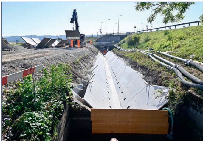
Sanierungsarbeiten am Aarmattenkanal.
