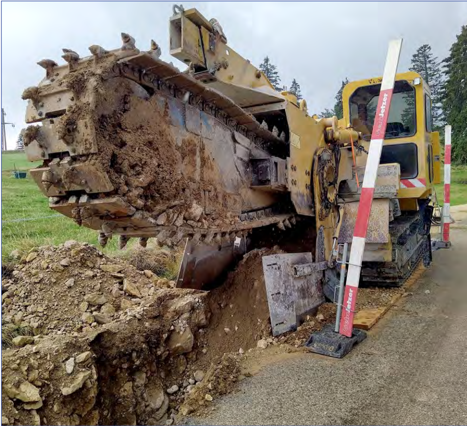
Hier funktionierte die Grabenfräse zum Ausheben der Leitungsgräben noch.
