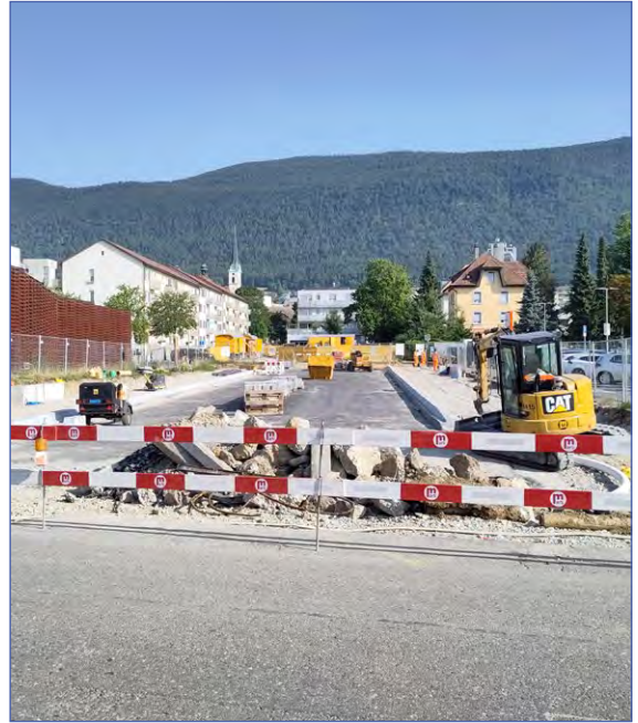
Links: So präsentierte sich die Situation beim künftigen Busterminal beim Start der Bauarbeiten. Bild vom 4. April 2023
