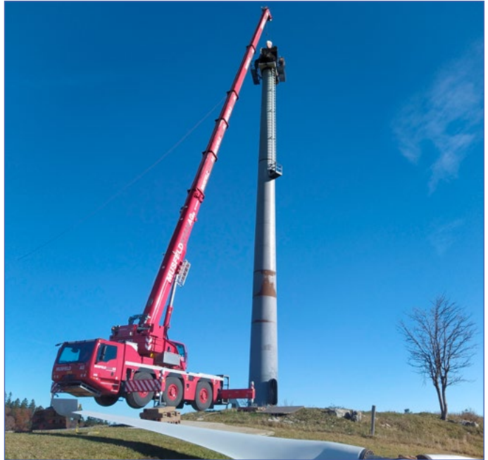
Abbau nach 27 Jahren: die Windenergieanlage auf dem Oberberg
