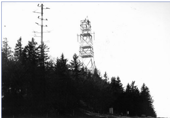
1972 wurde die 28 Meter hohe Antenne auf dem Untergrenchenberg errichtet.
