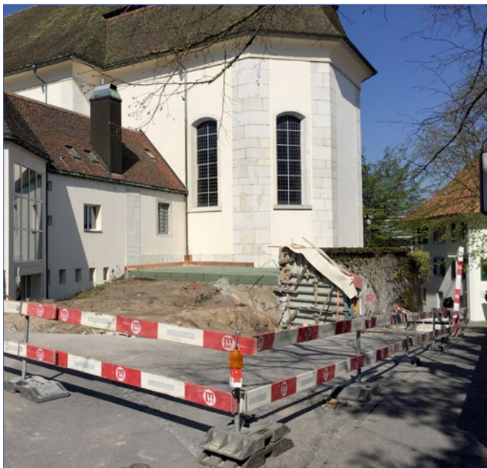
Links: Die Mauer bei der Absyde ist weg und gibt den Blick frei auf den Chor der Kirche und die Taufkapelle.
