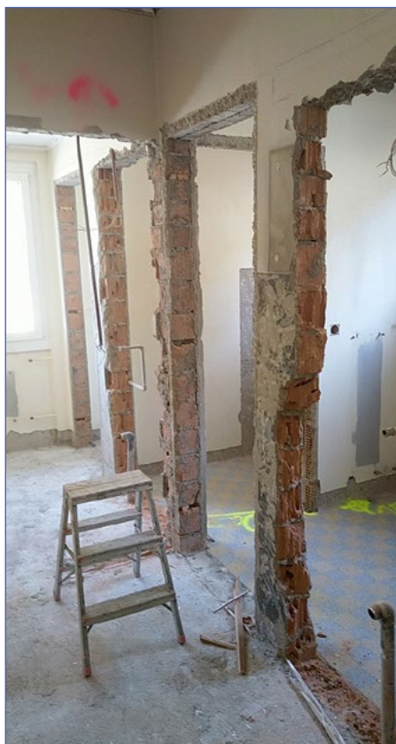
Im Berggasthof Stierenberg werden während der Zwangsschliessung Sanierungsarbeiten vorgezogen.
