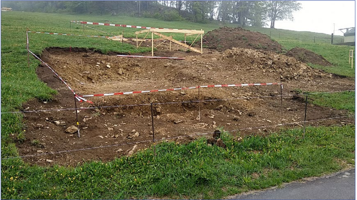
Hier wird auf dem Grenchenberg das neue Kassenhäuschen des Skilifts stehen.
