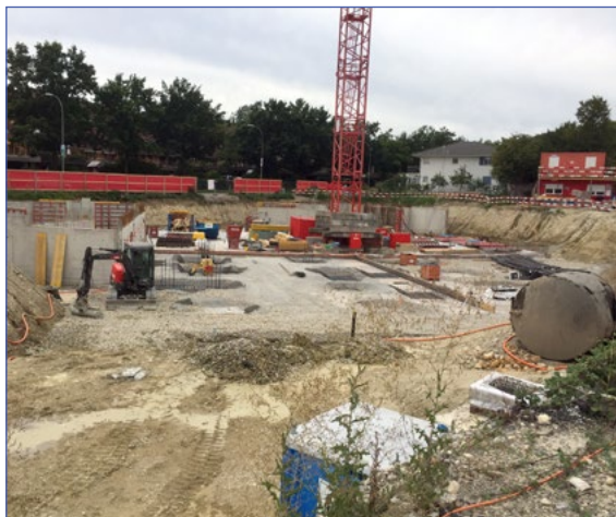
Links: Die grosse Baugrube gehört zur neuen Überbauung auf dem ehemaligen Areal der Firma Kaltbrunner an der Schlachthausstrasse. Foto vom 19. August 2020
