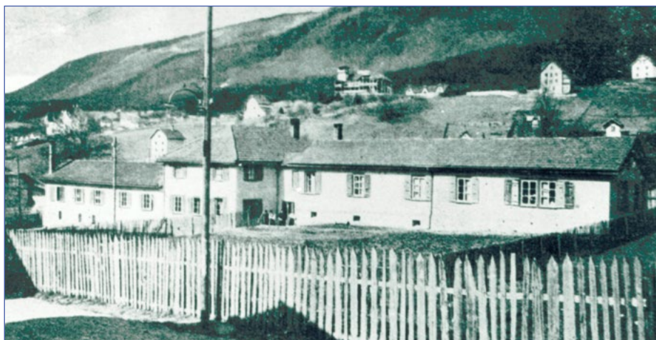
Tripoli-Spital, in dem die Erkrankten der Spanischen Grippe untergebracht wurden.
