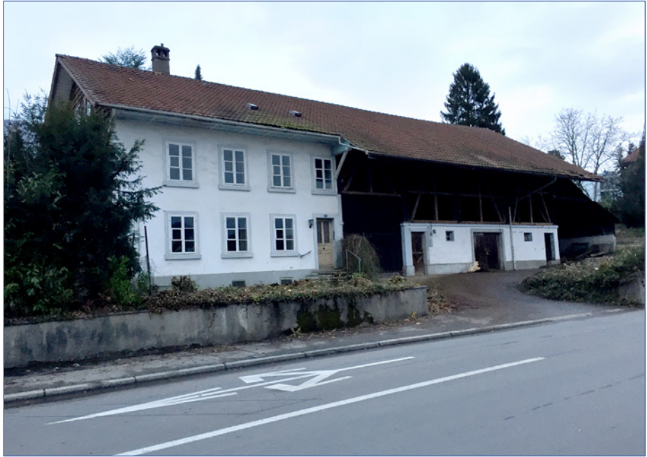
Verschwunden I: Das Bauernhaus an der Bettlachstrasse kurz vor dem Abbruch. Foto vom 29. November 2017.
