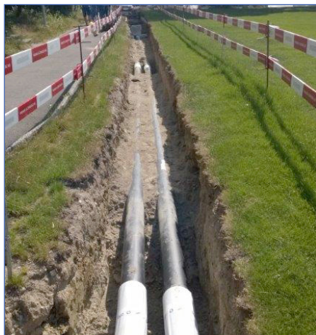
Das Leitungsnetz für den Wärmeverbund wird an der Lindenstrasse erweitert.
